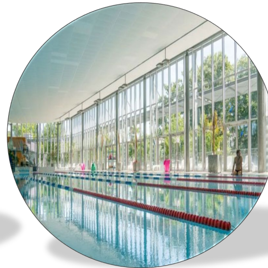
Piscine Petit Port
